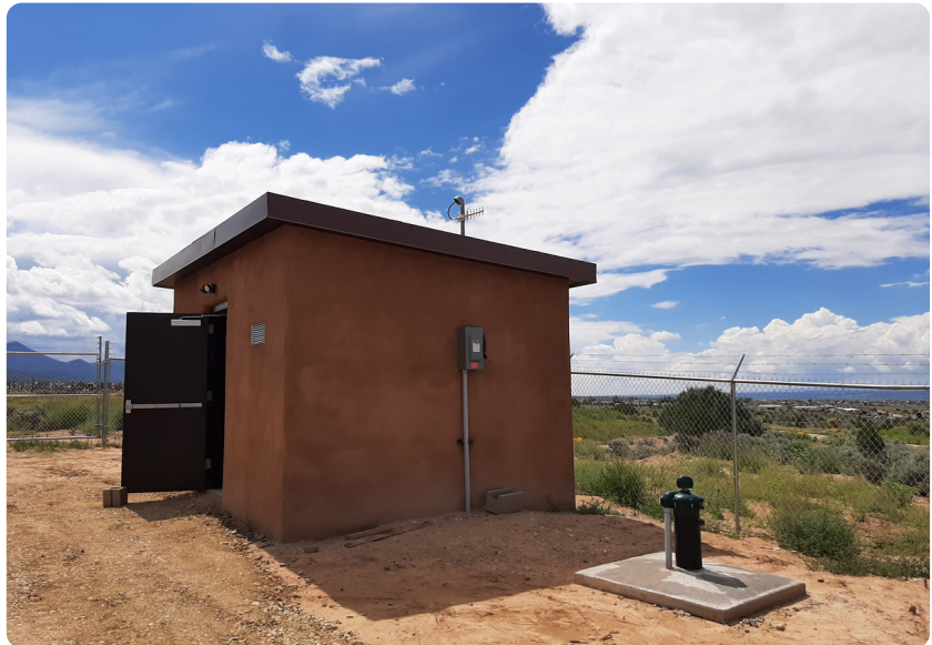
Llano Quemado MDWCA RIP 00034 Well Improvements.
