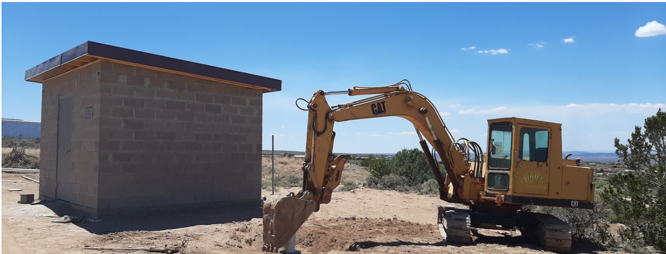
Llano Quemado MDWCA RIP 00034 Well Improvements.
