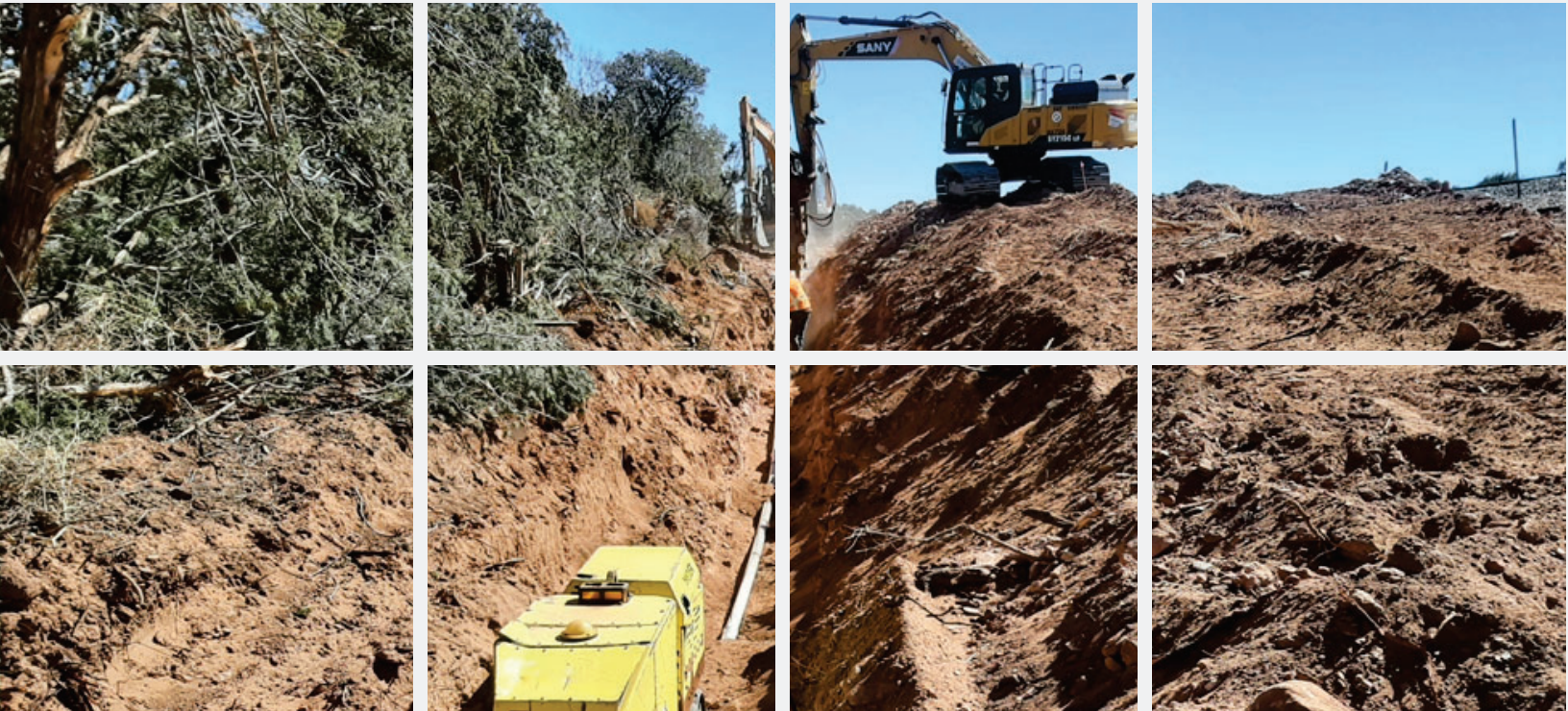
Chapelle MDWCA RIP 00044 Construction of New Waterline.
