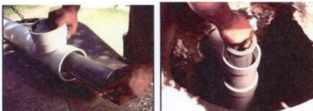
Figura 6. El tanque séptico requiere un filtro de salida o un Bioscreen
