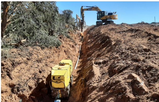
Chapelle MDWCA RIP 00044 Construction of New Waterline.
