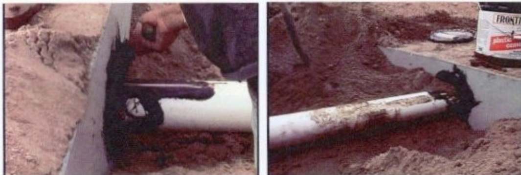
Figura 8. Entrada/salida de tubería, sello que muestra el
