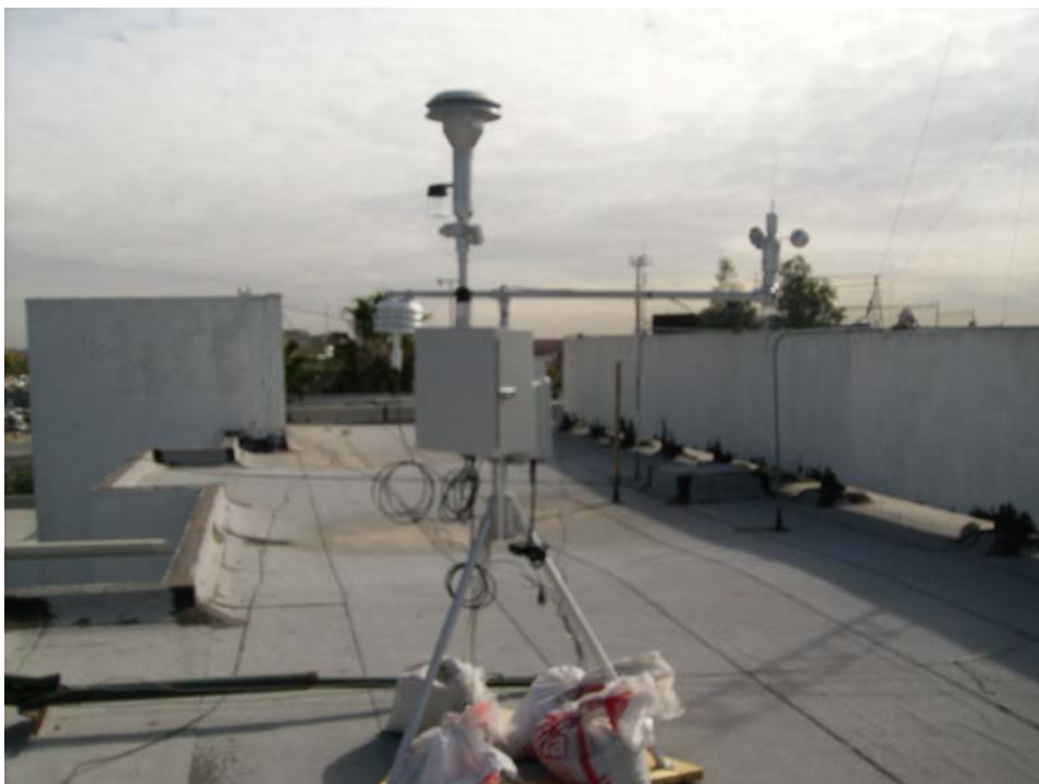
Foto 2. Sitio 21, Monitor instalado en Azotea de Central de Bomberos.
