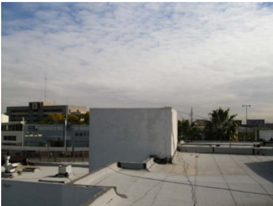
Foto 6. Sitio 21, Vista Oriente
