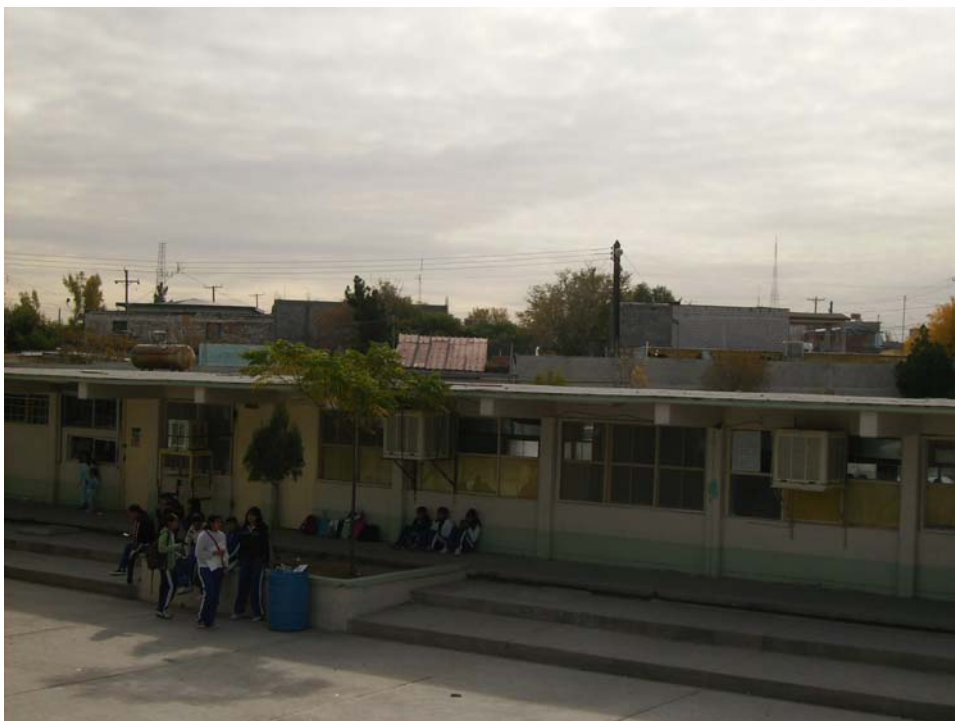
Foto 6. Sitio 20, Vista Oriente
