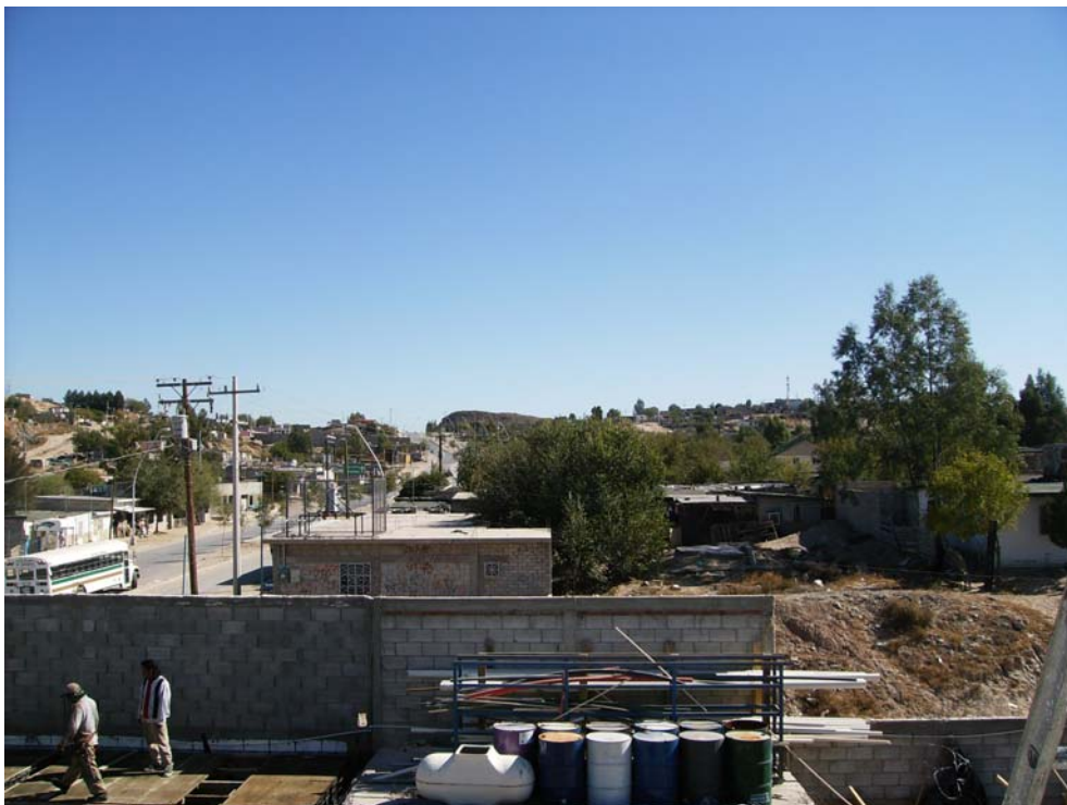
Foto 6. Sitio 17, Vista Oriente
