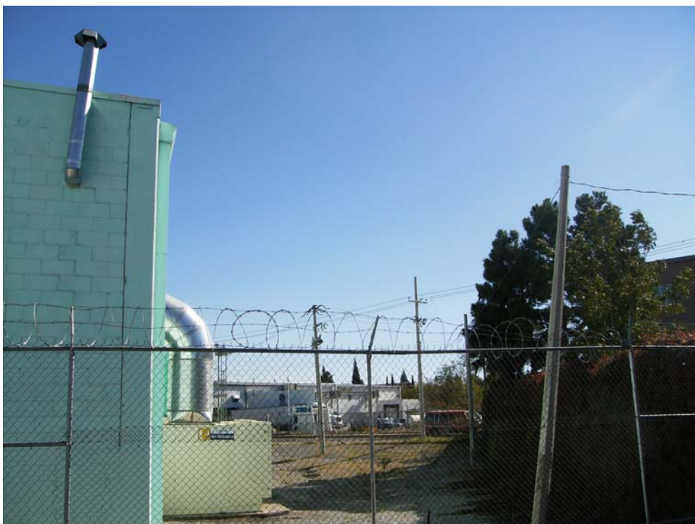
Foto 6. Sitio 19, Vista Oriente
