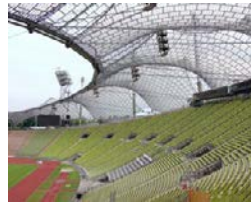
Construcción y edificación
