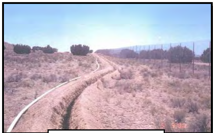
Caja del Rio pipeline
