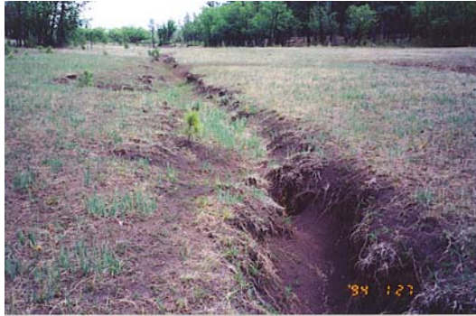
Erosion on Natividad Roybal property
